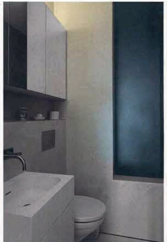
Der mineralische Zement wurde in den Bädern auch für die Wände verwendet und anders als am Boden eingefärbt.
